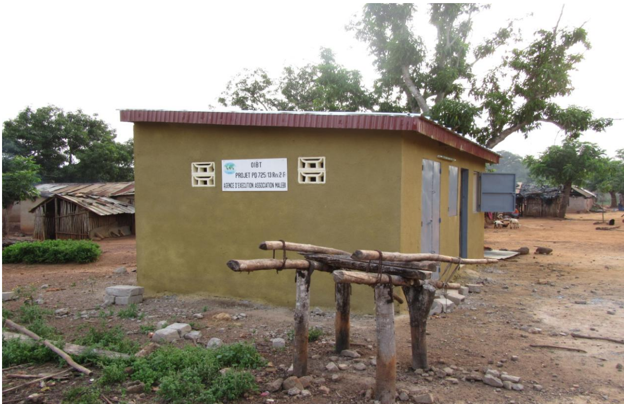
Construction d'un magasin pour abriter les équipements et vivriers
